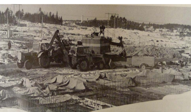
Pågående byggnation vid Hallenbergen. Skanska cementgjuteriet byggde alla bostadshus. Mark och grundarbetet utfördes av en annan entreprenör. Som mest var det 500 personer som arbetade med bygget.
